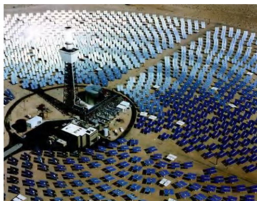
Σχήμα 13. Σύστημα κατόπτρων με κεντρικό πύργο συλλογής στην έρημο Mojave στην Καλιφόρνια
