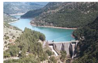
Σχήμα 15. Το φράγμα του Λάδωνα.
